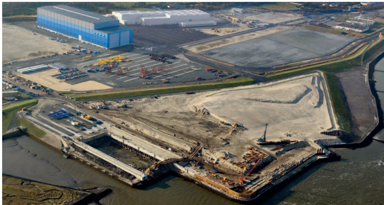
Die Erweiterungsfläche für den Offshore-Basishafen in Cuxhaven wächst heran. Am 20. März soll sie fertig sein.
